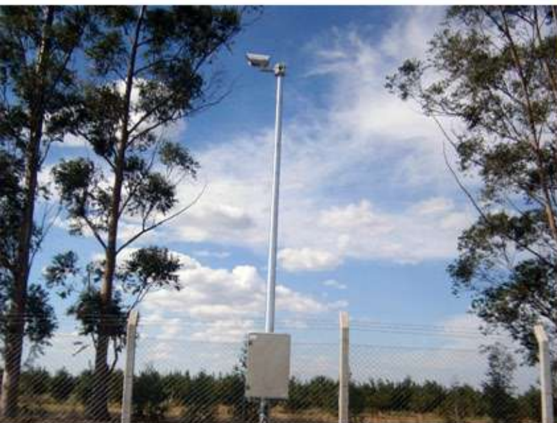
Planta Fotovoltaica La Jacinta
